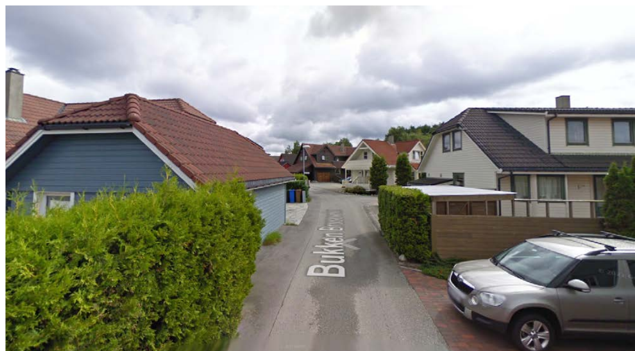
Figur 10- Bygningsstruktur, sett fra Bukkenes Brusesvei
